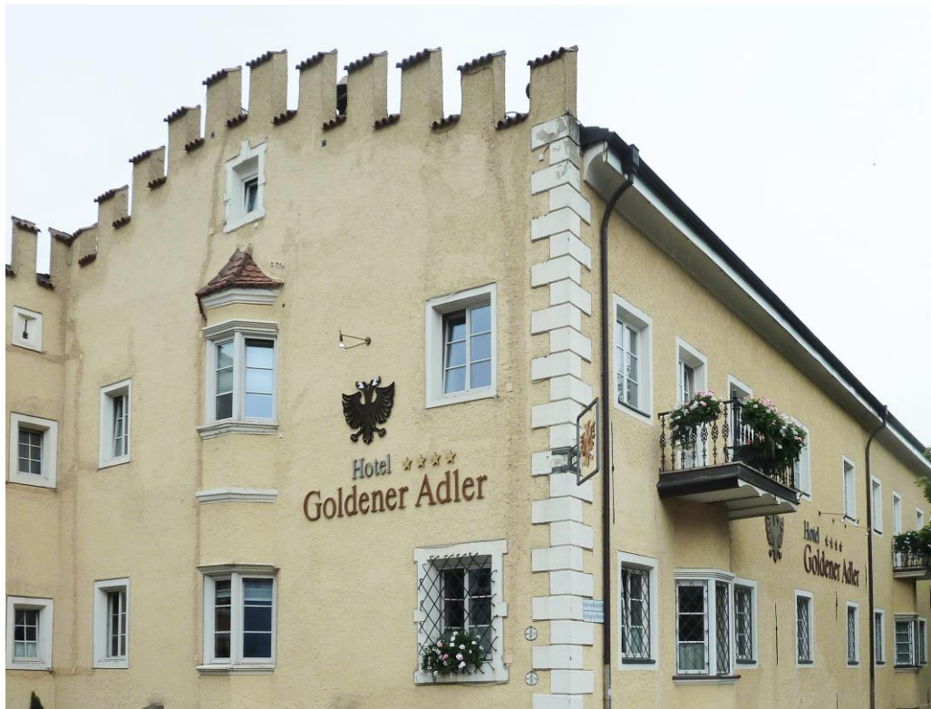
Foto 2_ Zufahrt Adlerbrücke / Ingresso da Via Ponte Aquila alto
