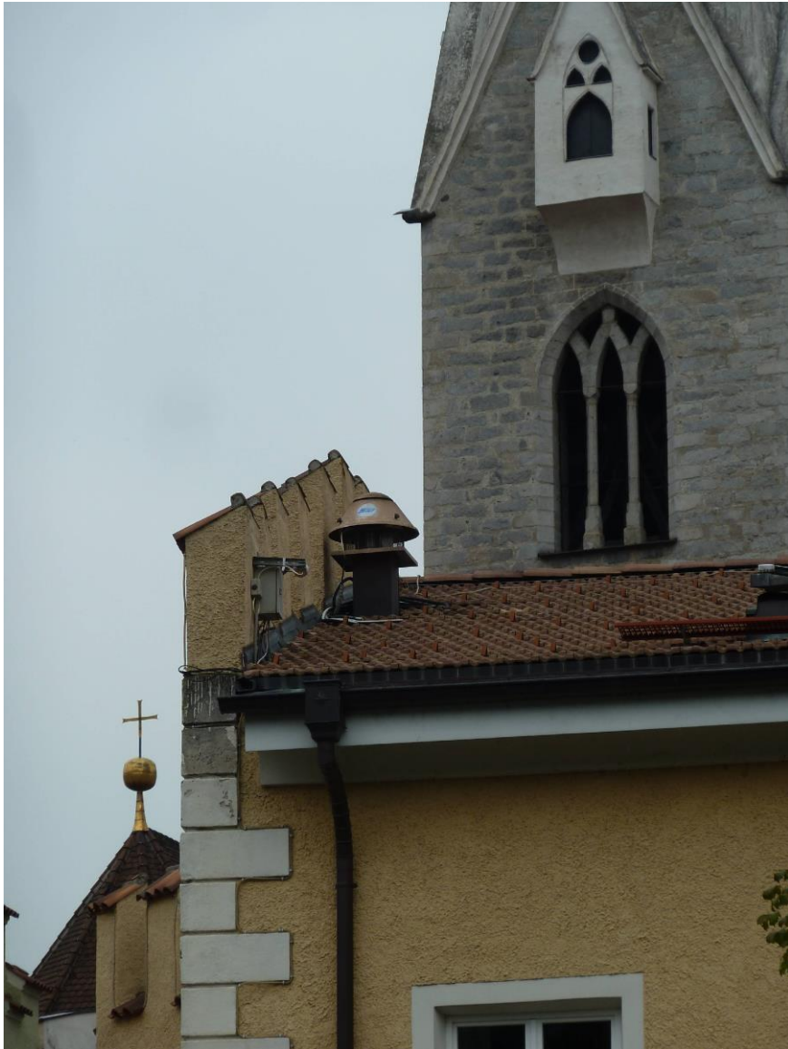
Foto 4_ dettaglio merlature in copertura
