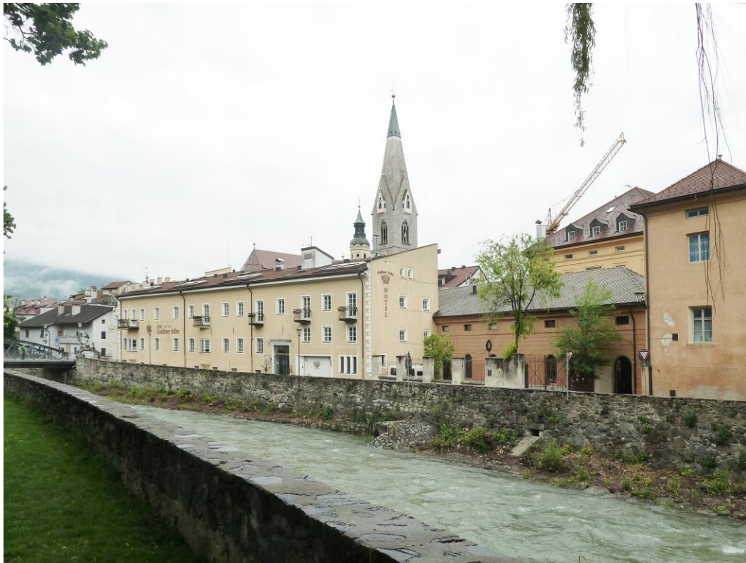
Foto 1_ prospetto est affaccio sul fiume
